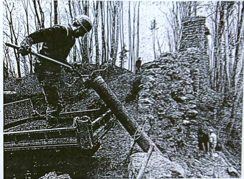
Neues Leben auf dem Melchnauer Schlossberg: Die vorhandenen Mauerreste von Burg Grünenberg werden einer umfassenden Sanierung unterzogen.
