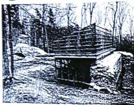
Neuer Schutzbau über Kapellenboden
