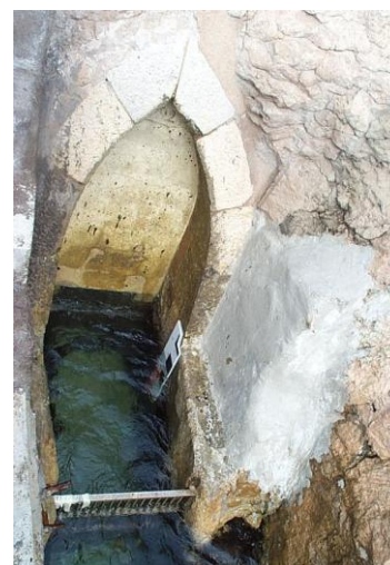
Figure 3 : échelle de marée à l'entrée de la galerie de communication du puits avec la mer
